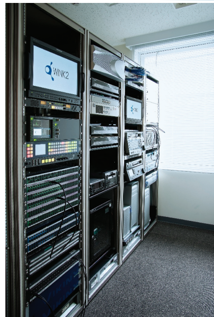
OL-5.6共通マシンルーム
